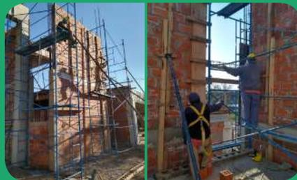
Por otra parte, se continuó con el cierre de la fachada oeste, el levantamiento de paredes y cerramiento del núcleo de escalera. A esto se sumaron los trabajos correspondientes a la terminación del tendido de la red cloacal. De este modo, en el mes de julio, tras el relevamiento de las autoridades Federativas sobre el estado alcanzado en la nueva "Sede Institucional y Centro de Entrenamiento y Capacitación" se registraron los siguientes avances:
